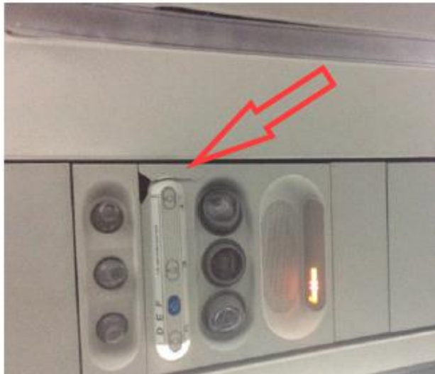
Foto 2: overhead passenger service unit danneggiata.
